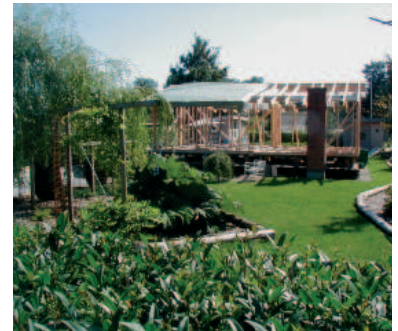
III. 3. Bygning under opførelse i havekolonien Storåen.
