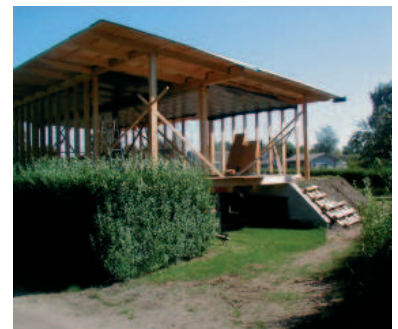
III. 5. Bygning under opførelse i havekolonien Storåen.
