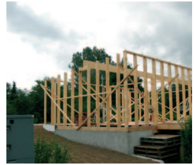
III. 2. Bygning under opførelse i havekolonien Storåen.
